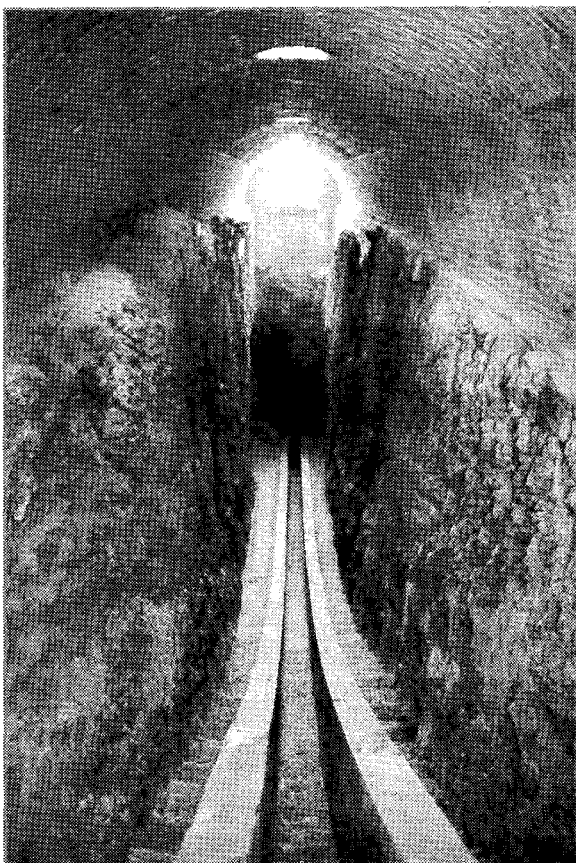
Главный инструмент обсерватории - стенной квадрант. Он был одним из важнейших наблюдательных инструментов дооптической астрономии. Ранее самыми крупными были стенные квадранты ал-Бируни ( R = 7,5 м), Насир ад-Дина ат-Туси ( R = 6,5 м), но обсерватория в Самарканде их намного превосшла ( R = 40 м)
